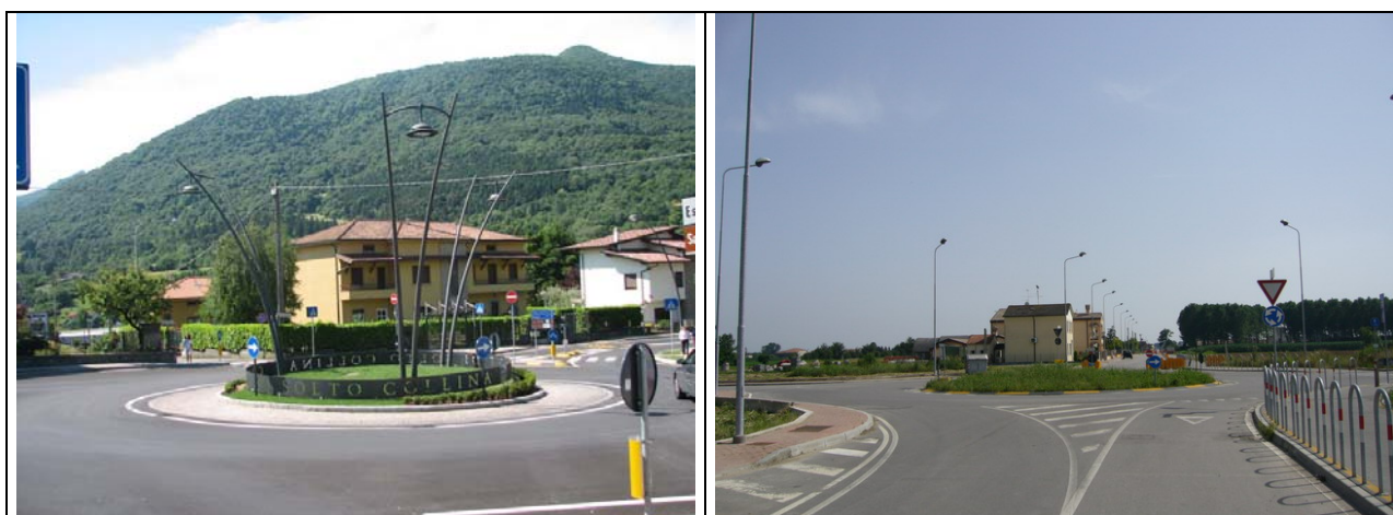
Fig 19 - -Impianti di rotonde tradizionali conformi alla L.r.17/09 con apparecchi posti centralmente o esternamente alla rotonda.
